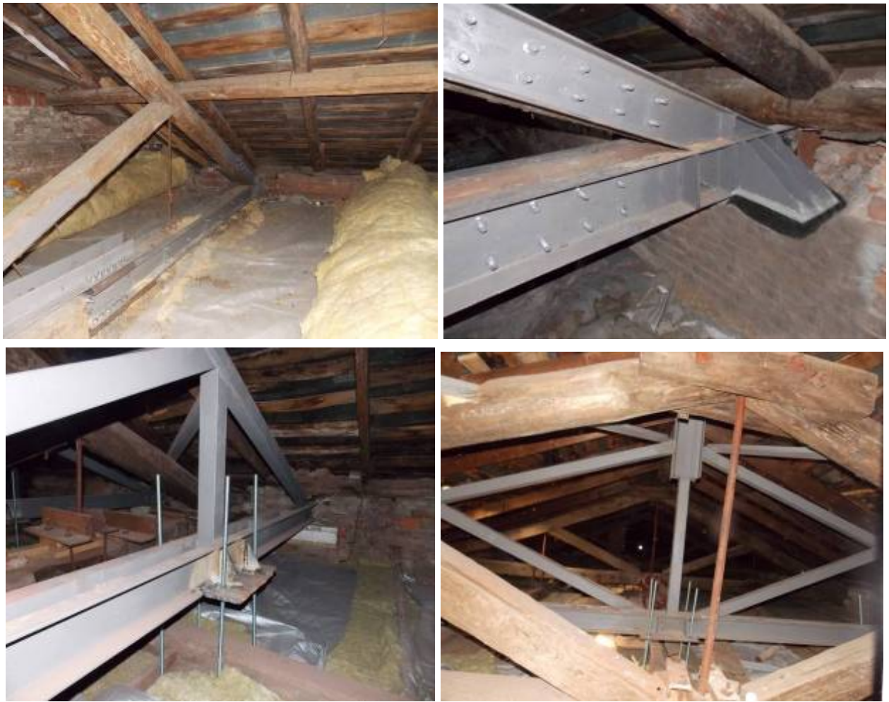
Капітальний ремонт несучих конструкцій даху навчально-лабораторного корпусу
