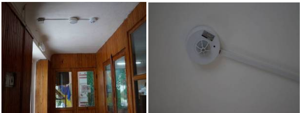
Установлення енергоефективних світильників із датчиками руху
