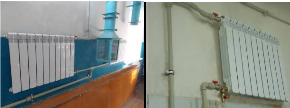
Ремонт мереж теплопостачання та опалення
