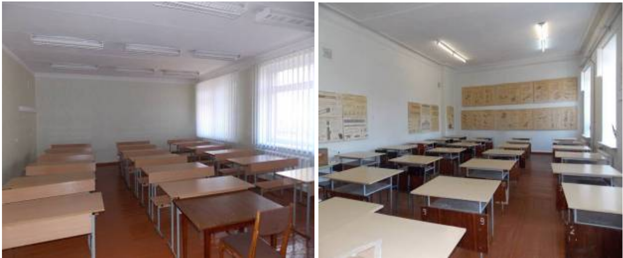
Ремонтні роботи у навчальних аудиторіях із заміною меблів силами меблевого цеху університету
