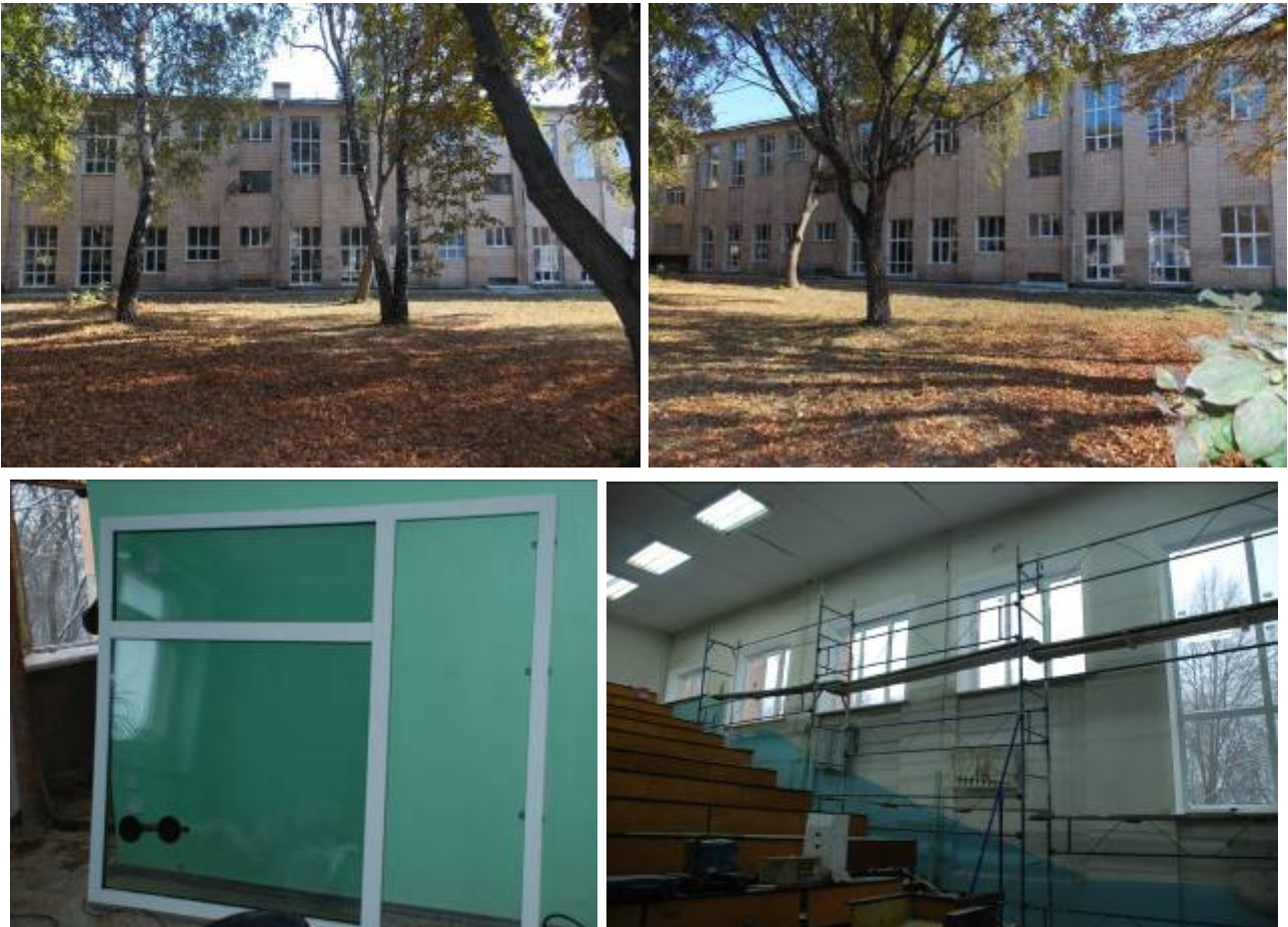
Термомодернізація навчальних корпусів шляхом заміни вікон на металопластикові енергоефективні склопакети
