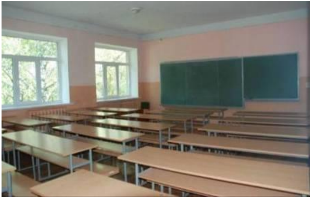
Виконання ремонтних робіт у навчальних аудиторіях
