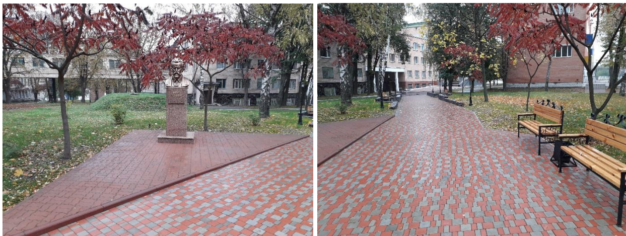
Благоустрій та влаштування пішохідних доріжок у внутрішньому дворі ПолтНТУ
