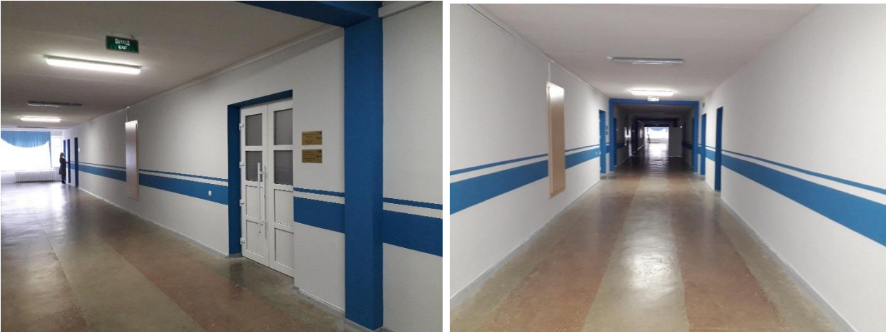
Капітальний ремонт коридору 4-го поверху корпусу «Ф»
