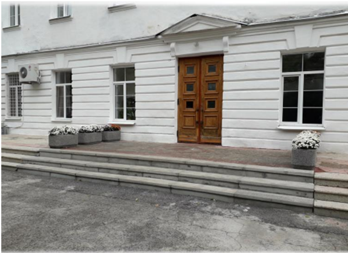
Відремонтовані сходи на виході з центрального корпусу до внутрішнього дворика.
