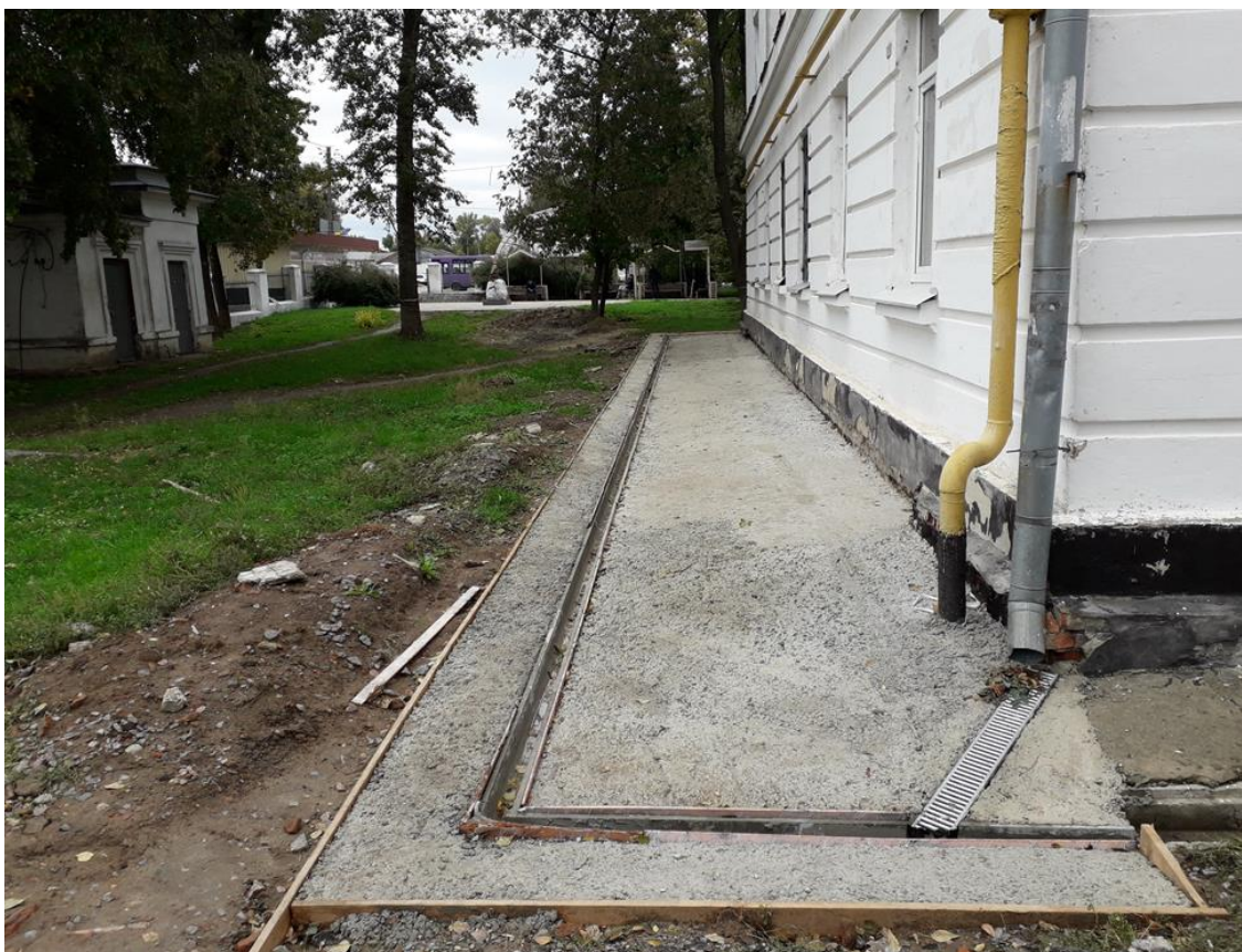
Капітальний ремонт відмостки будівлі гуртожитку №1
