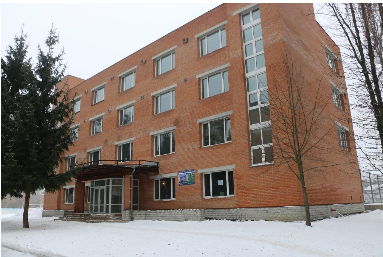
Будівництво спортивного корпусу ПолтНТУ
