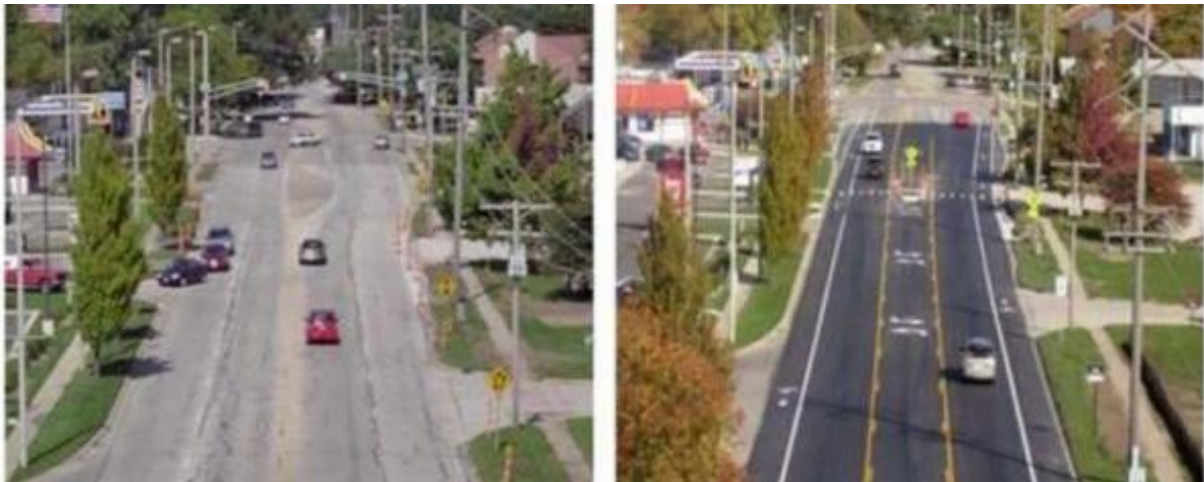
Рис. 2. Проміжні кроки реконструкції бульвару Вілсона у окрузі Арлінгтон, США (на другому етапі заплановано розширити тротуари і перенести опори освітлення) [3]
