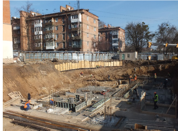
Рис. 2. Процес улаштування котловану
