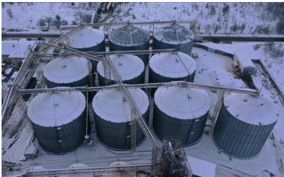
Рис. 1. Приклад елеватору з металевими силосами
