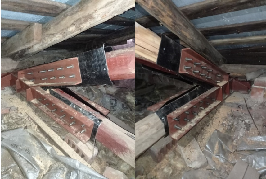
Рис. 1 . Загальний вигляд вузлів підсилення дерев'яних кроквяних ферм
