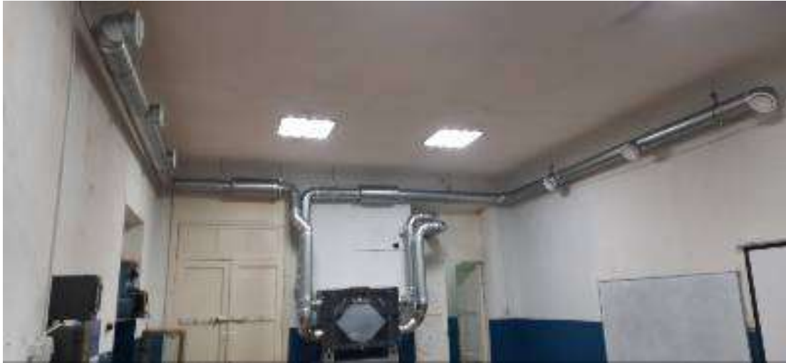
Рисунок 1 – Утилізатор (рекуператор) теплоти вентиляційного повітря
