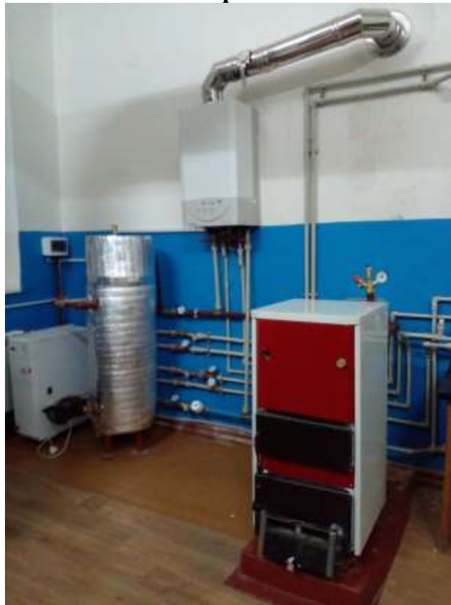
Рисунок 2 – Лабораторної установки для дослідження роботи тепло генеруючих установок на твердому та газовому паливі
