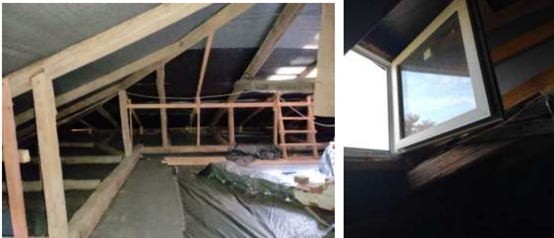
Рис. 1 – Загальний вигляд холодного горища експлуатованої будівлі
