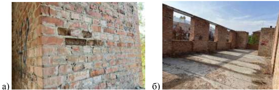
Рис. 3 – Причини пришвидшення морозобійного руйнування цегляної кладки: а) різна пористість цегли; б) незахищеність від атмосферних опадів
