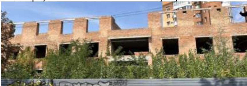
Рис. 1 – Загальний вигляд поздовжнього фасаду недобудованої будівлі
