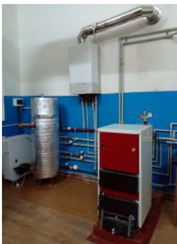
Рисунок 1 – Лабораторна установка для дослідження роботи котла на твердому паливі
