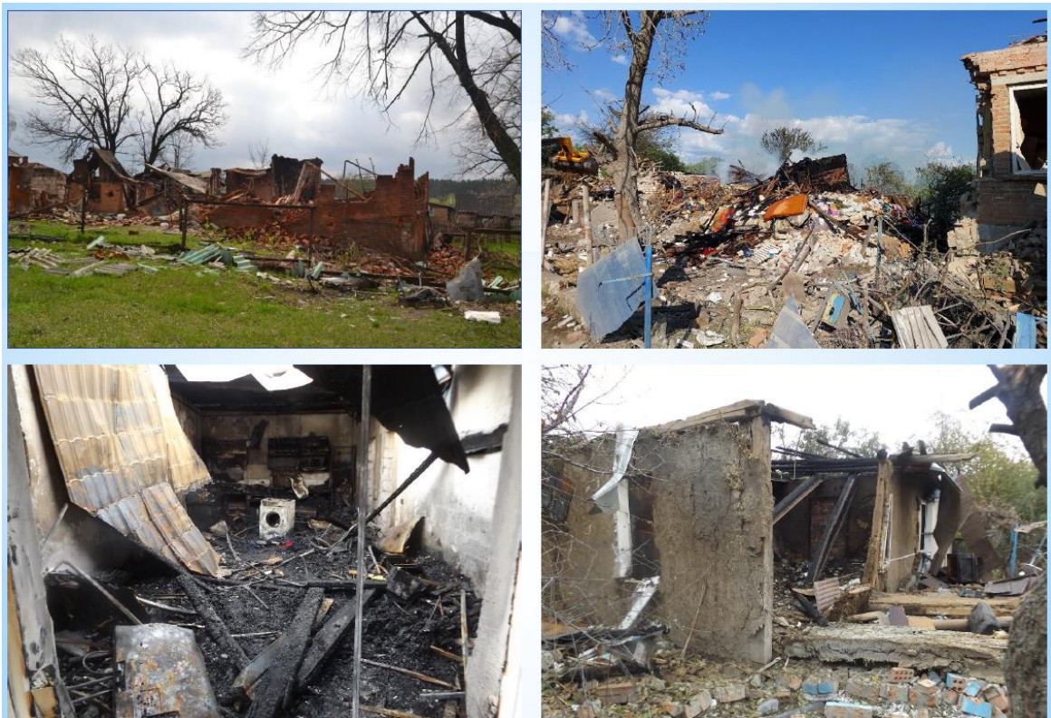
Рис. 1. Загальний вигляд зруйнованих житлових будинків внаслідок воєнних дій, спричинених російською агресією
