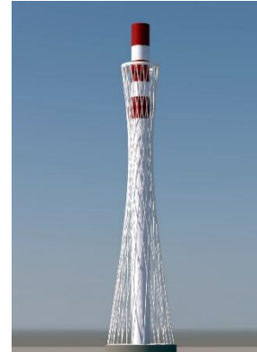
в. Фахверкова оболонка підтримуюча трубу
