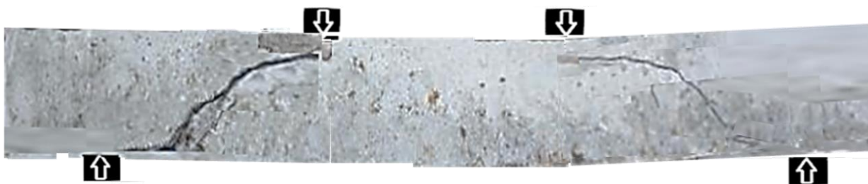
Рисунок 3 – Загальний вигляд балки Б-400-100 після руйнування за небезпечною похилою тріщиною
