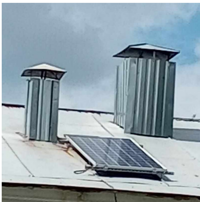
Рис. 1. Розташування фотоелектричної панелі AS-6P-340W на даху
