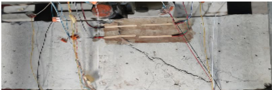
Рисунок 4 – Фрагмент ділянки балки Б-300-150 у місці руйнування
