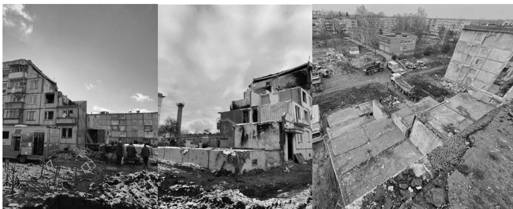
Рис. 2. Уражений ракетою будинок по вул. Баленка, 7
