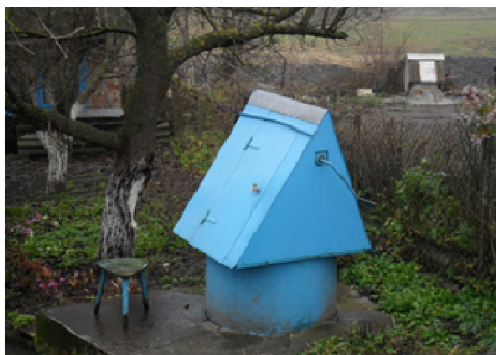
Рис. 2.4. Облаштування колодязів з порушенням вимог ДБН В.2.5-74:2013 «ВОДОПОСТАЧАННЯ ЗОВНІШНІ МЕРЕЖІ ТА СПОРУДИ»
