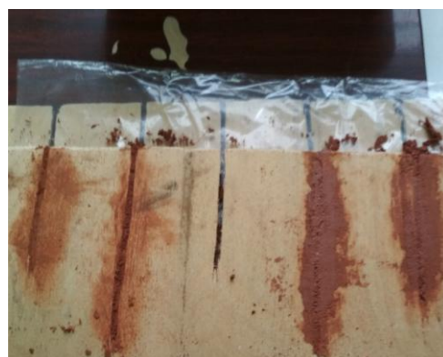
Рис.2.9. Заділ щілин у фанері масляною шпаклівкою
