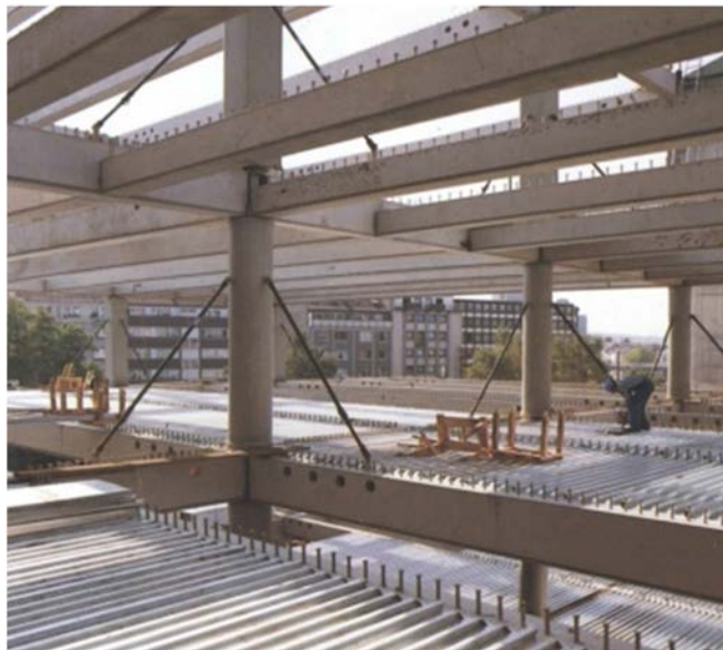
Сталобетонний каркас багатоповерхової виробничої будівлі
