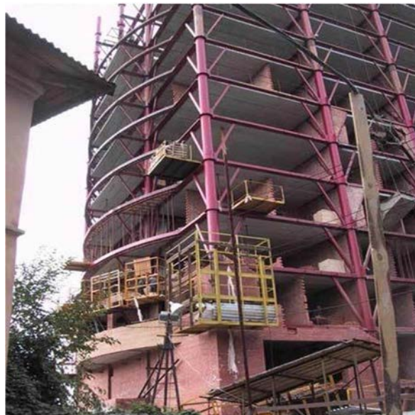
Житловий будинок під час будівництва
