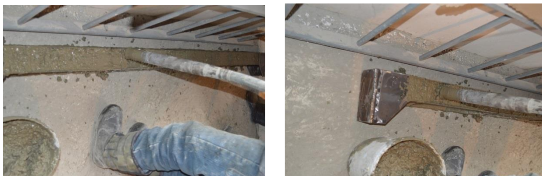
Рис. 2.8. Ущільнення бетону за допомогою віброущільнювача
