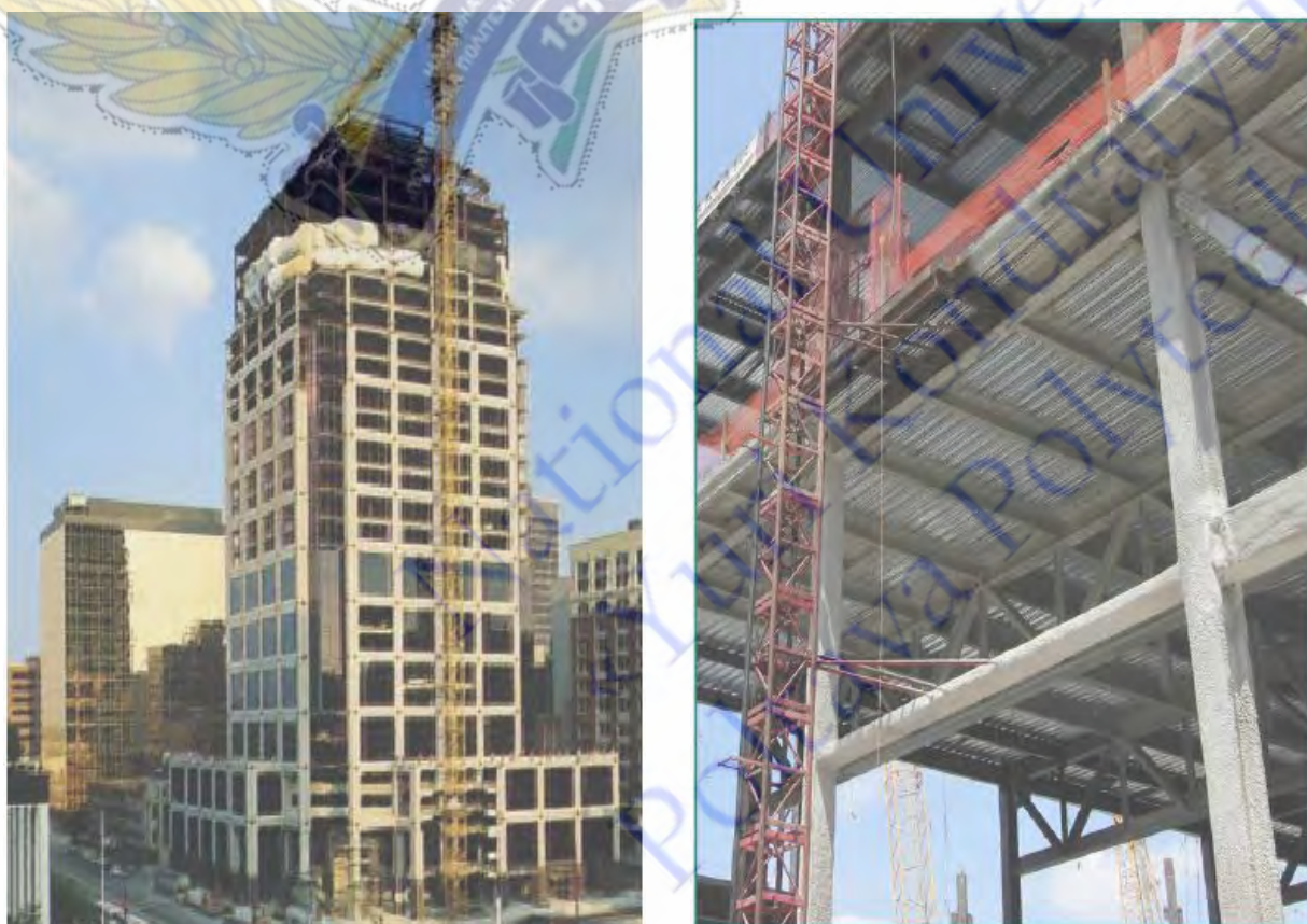
Рис. 1.1 Каркасна багатоповерхова будівля із сталезалізобетонними перекриттями поверхів
