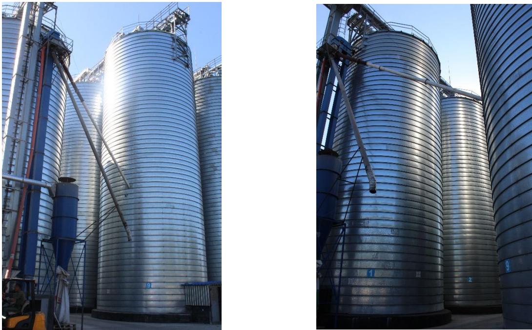
Рис. 5.27. Система бічного завантаження зерна
