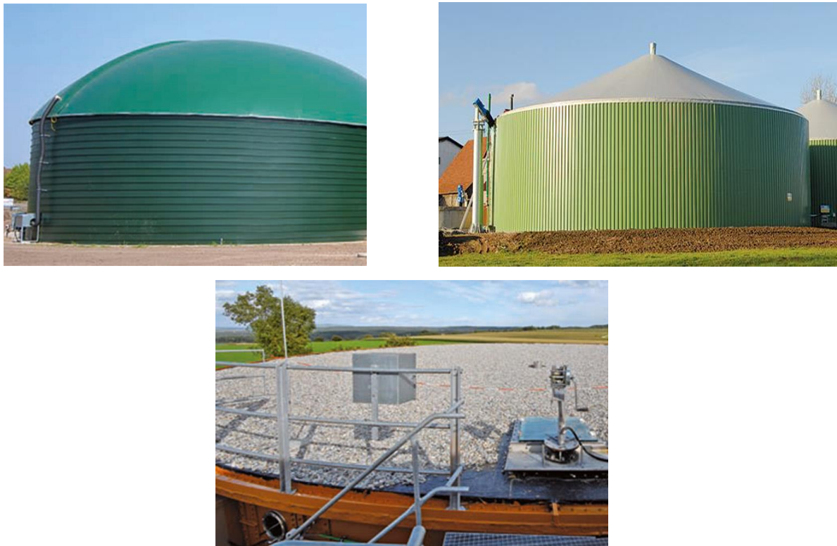
Рис. 2.18. Конструкції даху пост-метантенків
