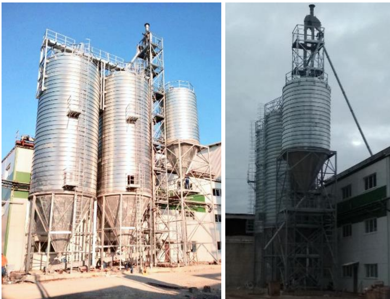
Рис. 5.5. Котельня, працююча на лушпинні соняшника, м. Кривий Ріг
