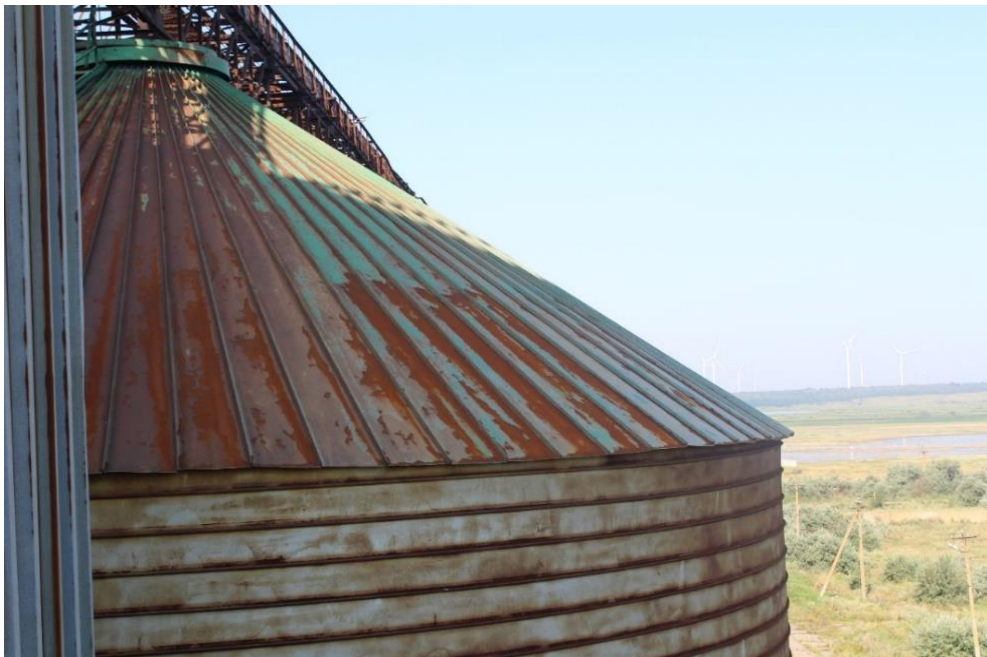
Рис. 5.13. Фальцева покрівля силосу
