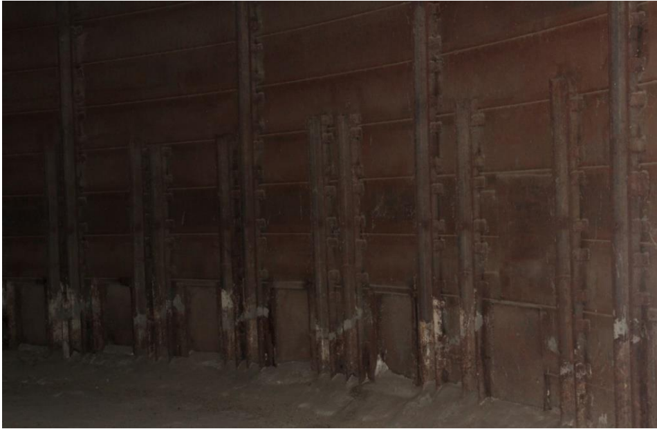
Рис. 5.12. Ребра жорсткості всередині силосу
