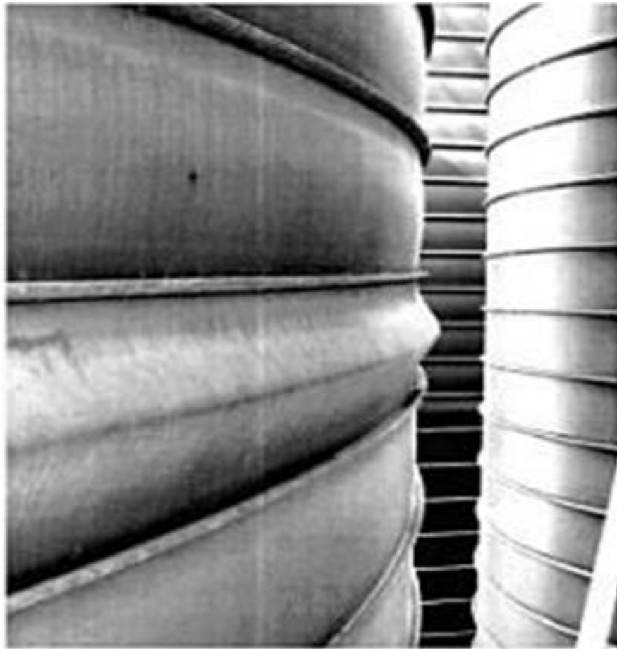
Рис. 4.1. Згин міжфальцевої зони стінки спіраль-фальцевого силосу
