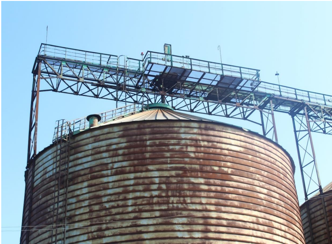
Рис. 5.16. Кріплення транспортної галереї на силос
