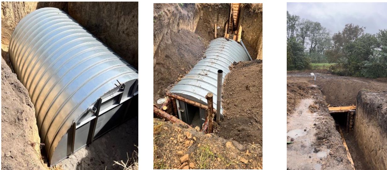
Рис. 2.24. Монтаж бункера-сховища
