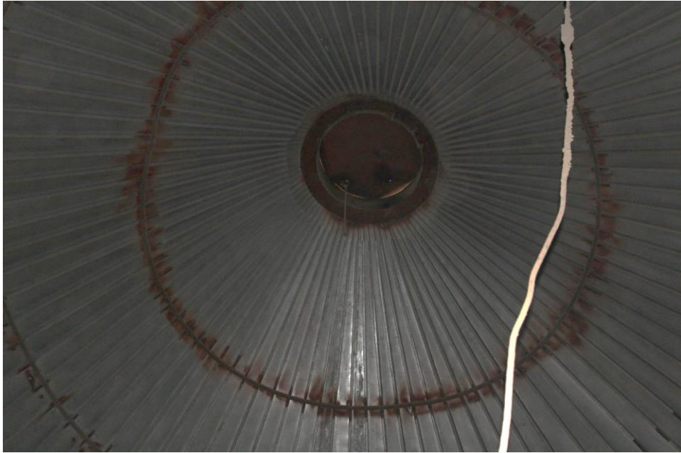
Рис. 5.14. Фальцева покрівля силосу, вигляд зсередини
