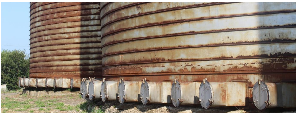
Рис. 5.19. Аероканали для підключення вентиляторів для розвантаження силосу
