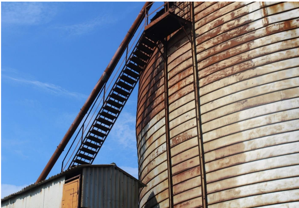
Рис. 5.16. Кріплення транспортної галереї на силос
