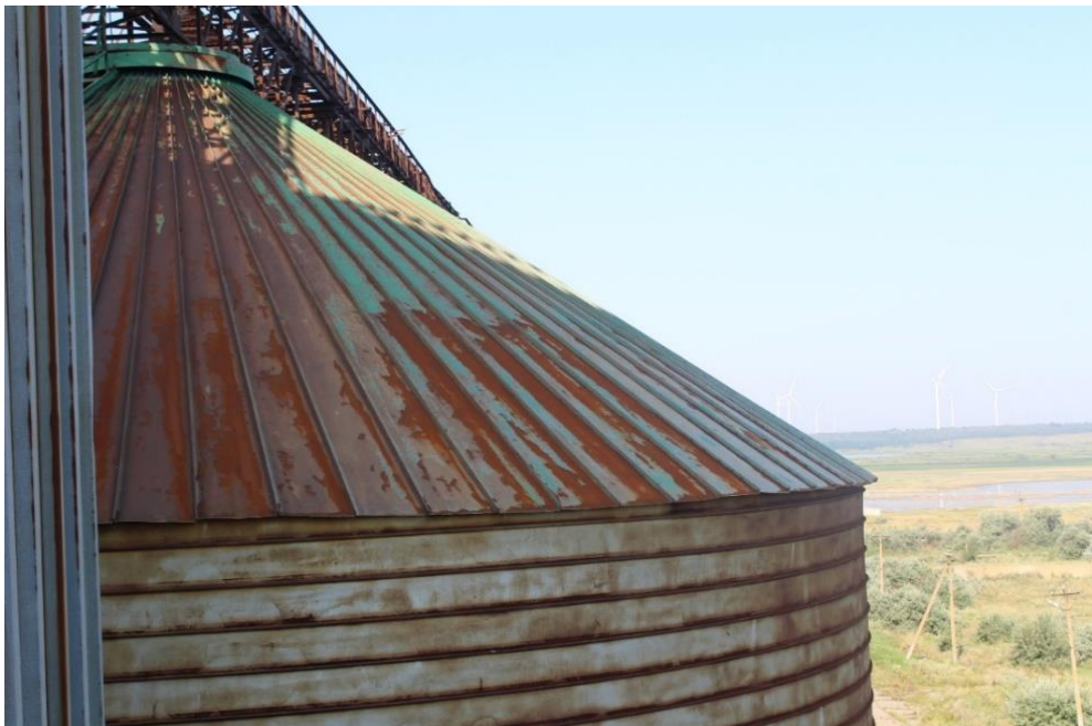
Рис. 5.13. Фальцева покрівля силосу
