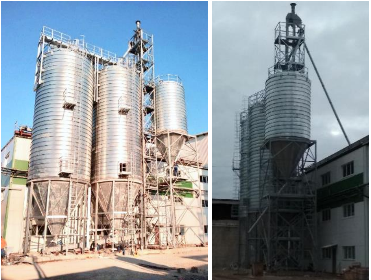
Рис. 5.5. Котельня, працююча на лушпинні соняшника, м. Кривий Ріг
