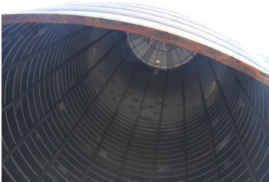
Рис. 5.23. Вертикальні ребра корпусу спіральньо-фальцевого силосу
