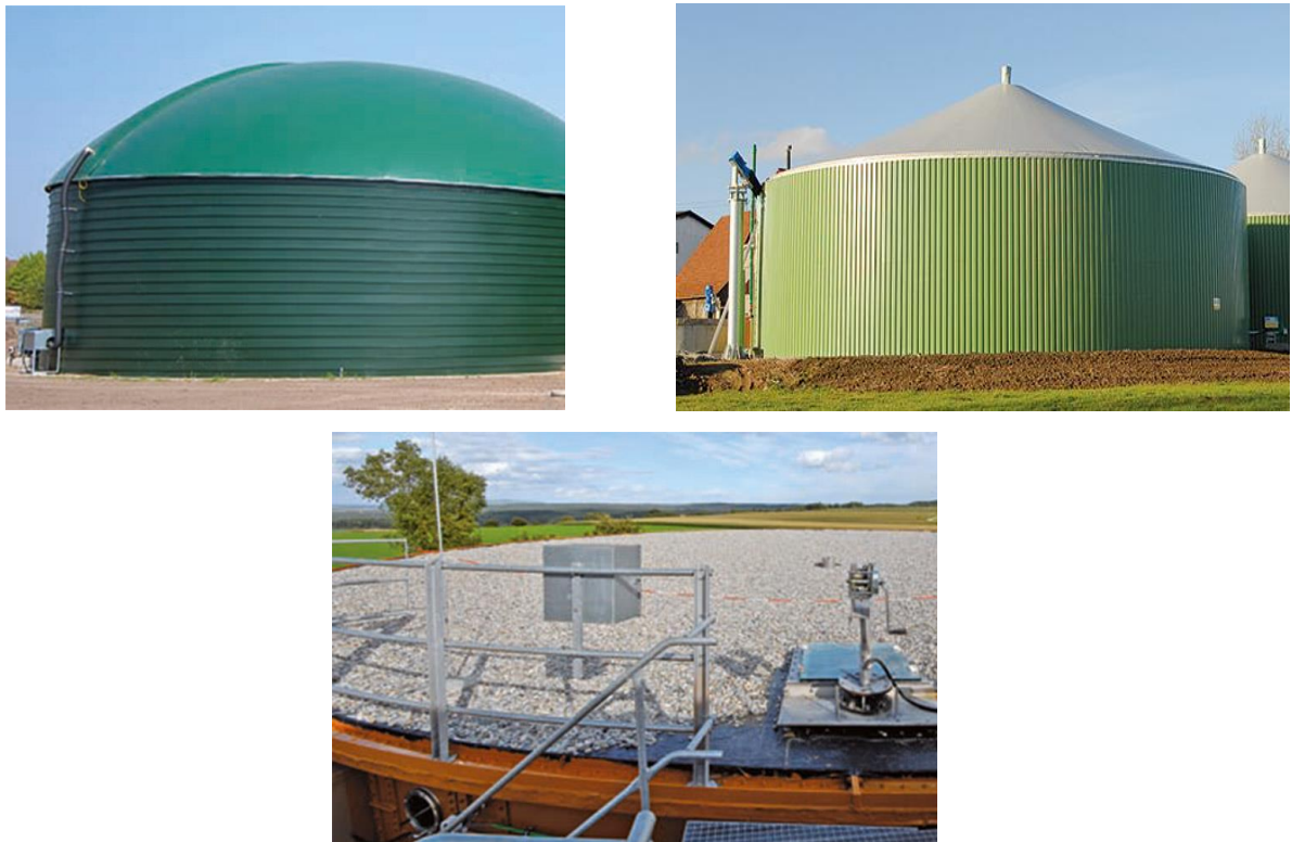
Рис. 2.18. Конструкції даху пост-метантенків
