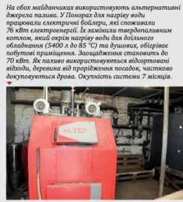
▲ Котельня на МГФ у Кориньському. Фундаментальні речі в роботі котельні: очищення води, насоси підкачки, безперервне живлення.
