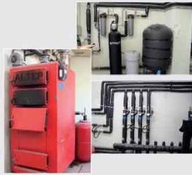
▲ Котельня на МГФ у Кориньському. Фундаментальні речі в роботі котельні: очищення води, насоси підкачки, безперервне живлення.
