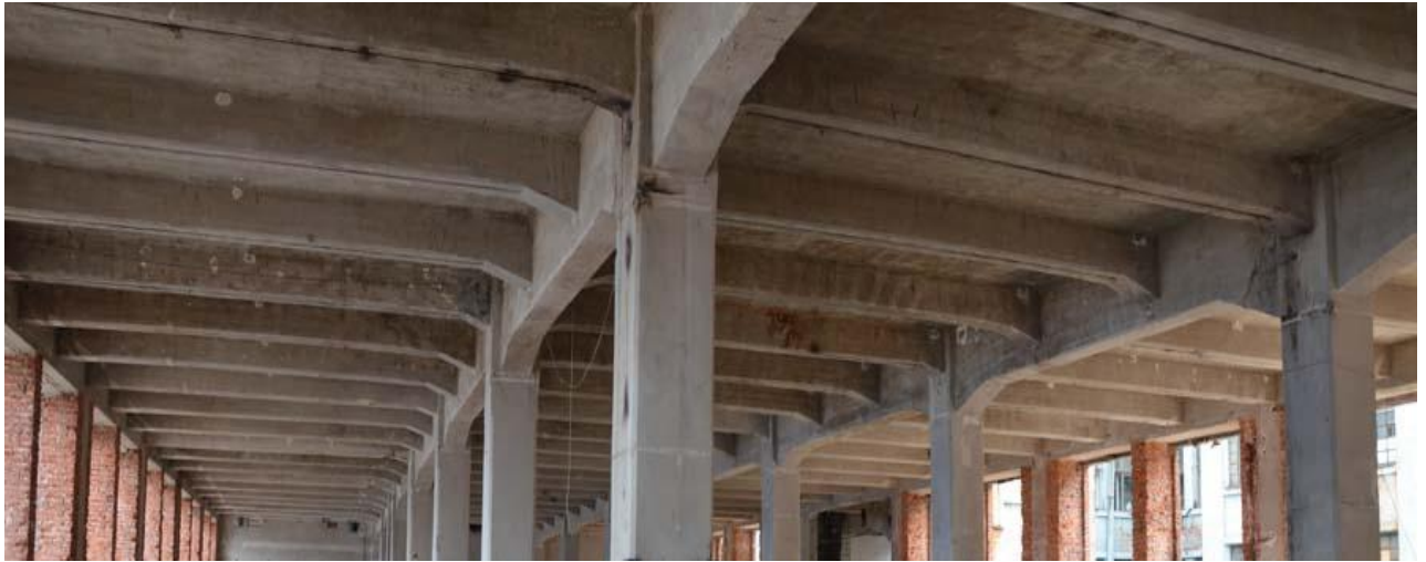
Рис. 4.9 Загальний вигляд балково-плитного монолітного залізобетонного перекриття будівлі, що підсилюється
