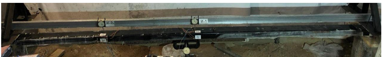
Рис. 3.2.2 – Загальний вигляд попереднього вигину сталеві частини перерізу балок серії ПСБ1 і ПСБ2
