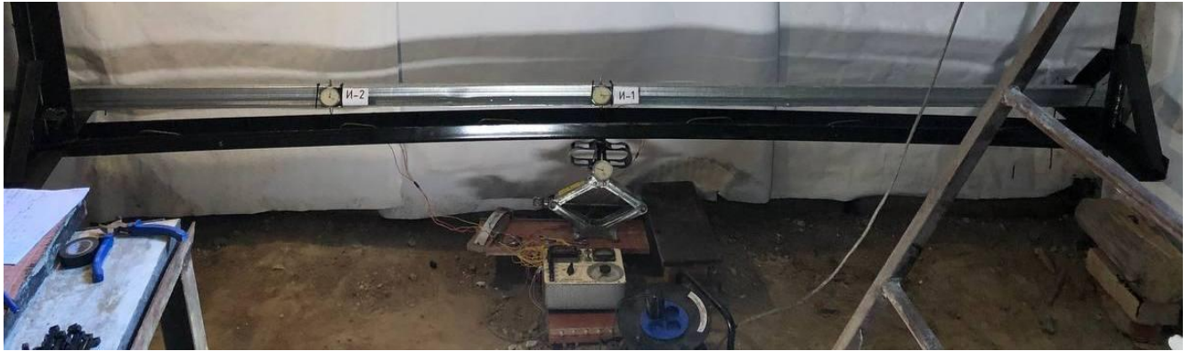
Рис. 3.2.4 – Загальний вигляд зразка із попереднім напруженням сталеві частини безпосередньо перед бетонуванням
