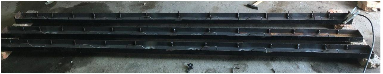
Рис. 3.2.3 – Загальний вигляд частини зразків, підготовлених до бетонування
