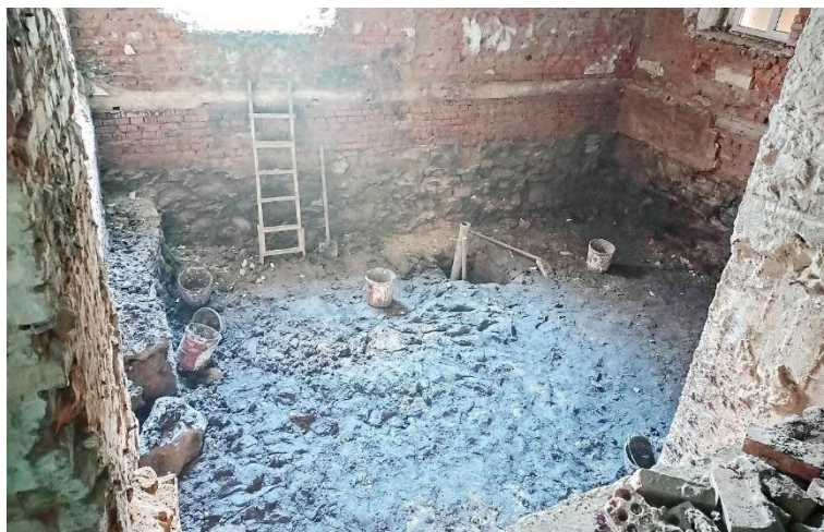
Рис. 4.2.4 – Підвальне приміщення, над яким треба виконати перекриття
