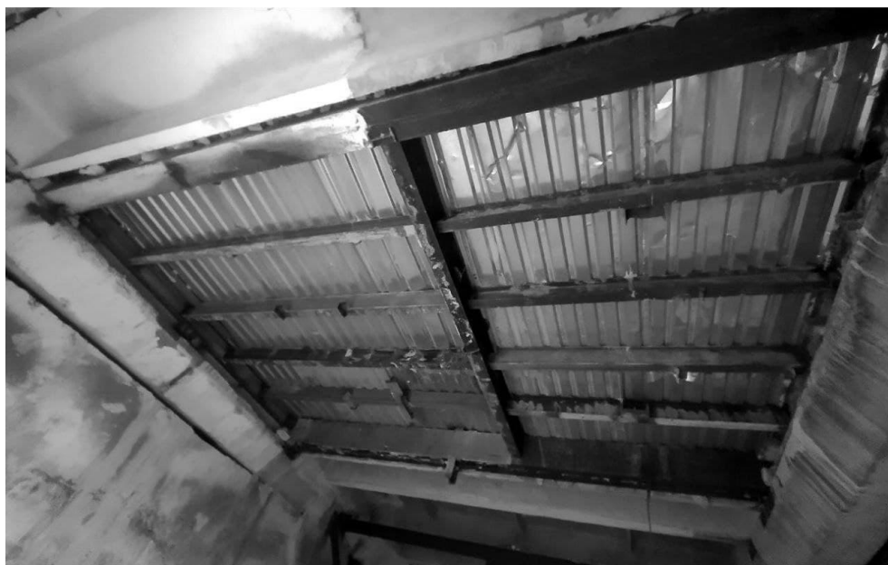
Рис. 4.2.3 – Загальний вигляд влаштування перекриттів у виробничій шахті ліфта
