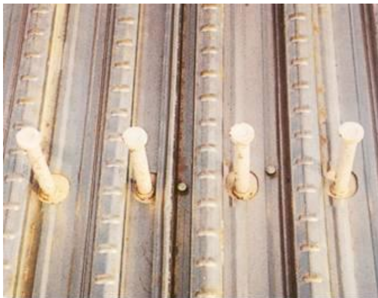
Рис. 1.3.9 – Гнучкі анкери по профнастилу
