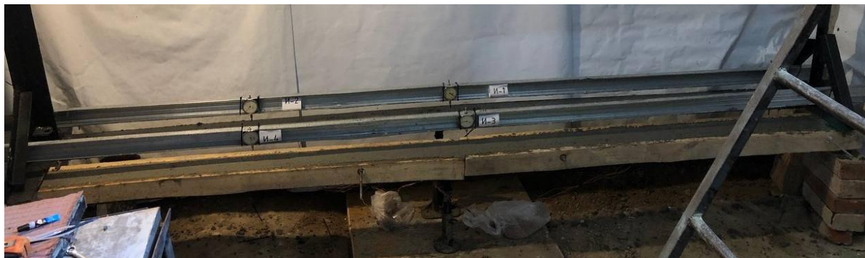
Рис. 3.1.9 – Загальний вигляд попередньо напруженої сталеві частини з холодноформованого швелера №10, приготуваних для заповнення бетоном
