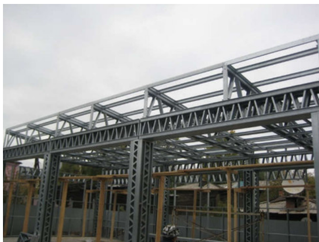
Рисунок 1.2. Малоповерхова будівля із ЛСТК
