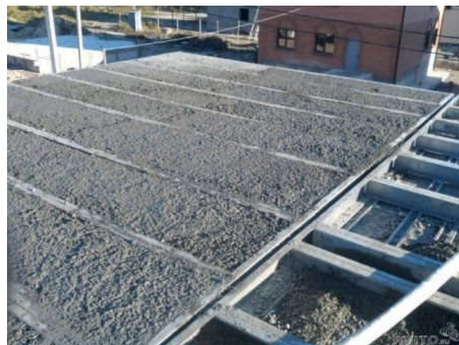
Рисунок 1.3. Сталезалізобетонне перекриття із полістиролбетону.
