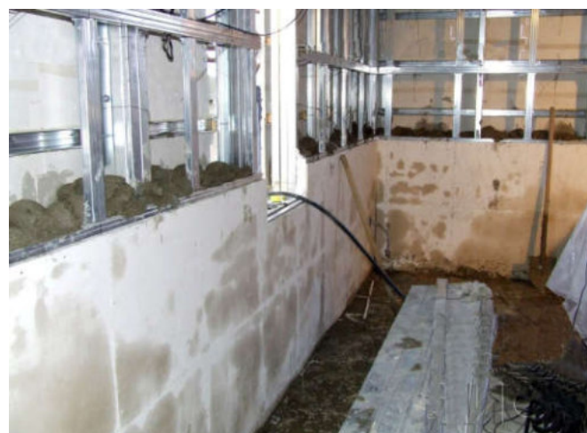
Рисунок 1.5. Утеплення каркасної будівлі із ЛСТК полістиролбетоном.
