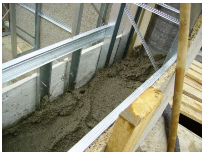
Рисунок 1.4 Заповнення полістиролбетоном зовнішніх огорожуючих конструкцій каркасної будівлі із ЛСТК
