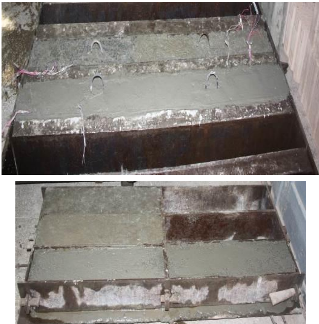
Рисунок 2.18 – Бетонування балок і призм
