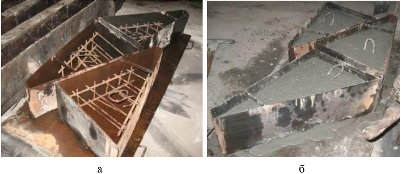
Рисунок 2.4 – Виготовлення дослідних зразків: а – арматурні каркаси в опалубці; б – процес бетонування
