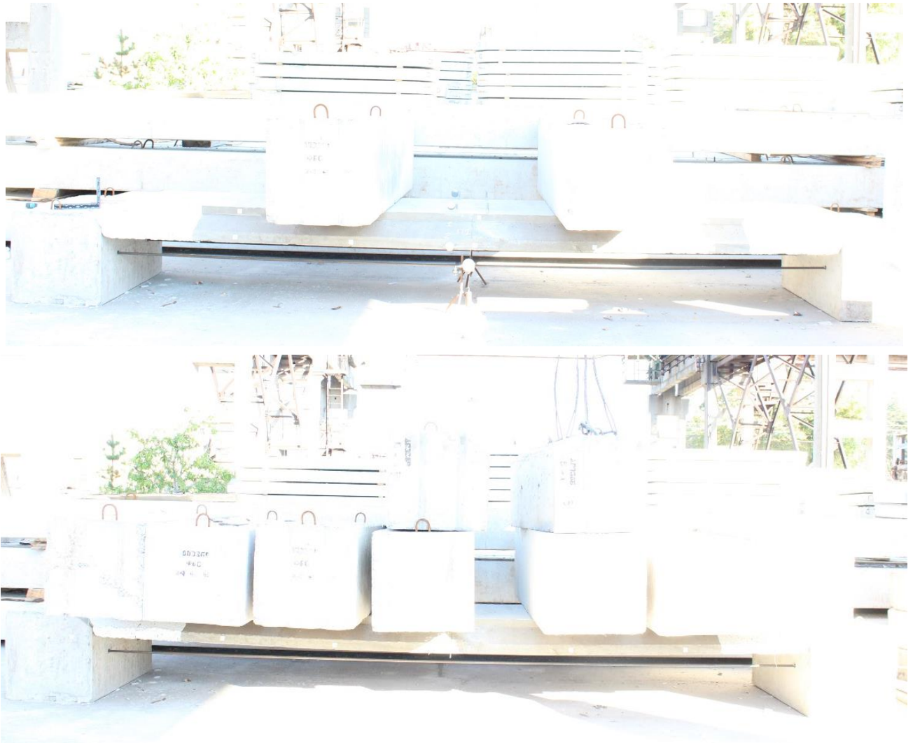
Рис. 3.29. Етапи завантаження міжколонної плити ПМК
