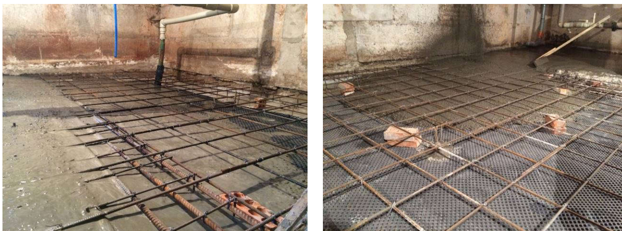
Рис. 5.5. Бетонування плити (шостий етап посилення фундаментів)
