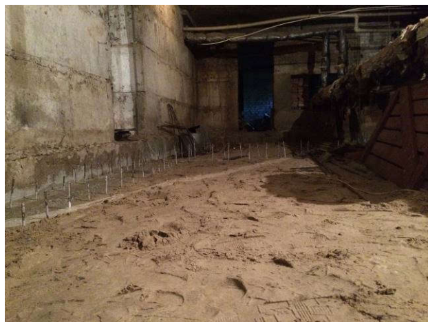
Рис. 5.3. Вигляд піщаної основи після її поверхневого ущільнення під плиту
