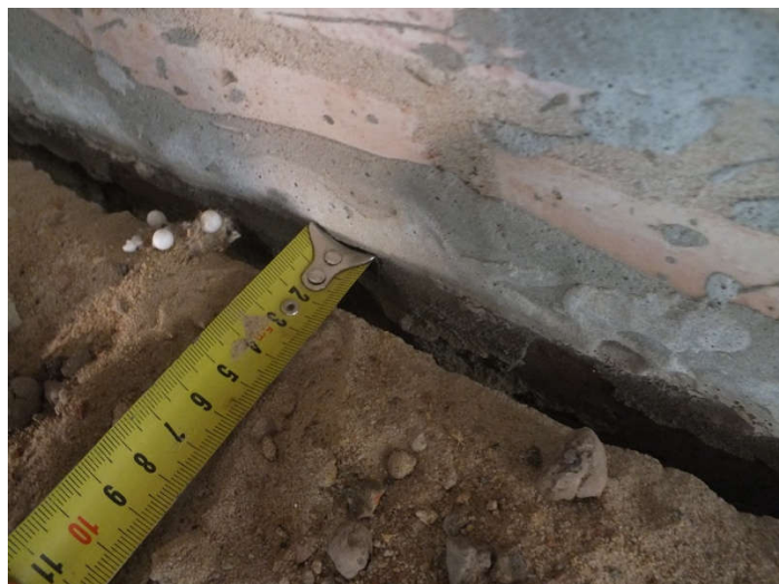
Рис. 5.12. Вертикальні тріщини між повздовжніми несучими та поперечними самонесучими стінами
