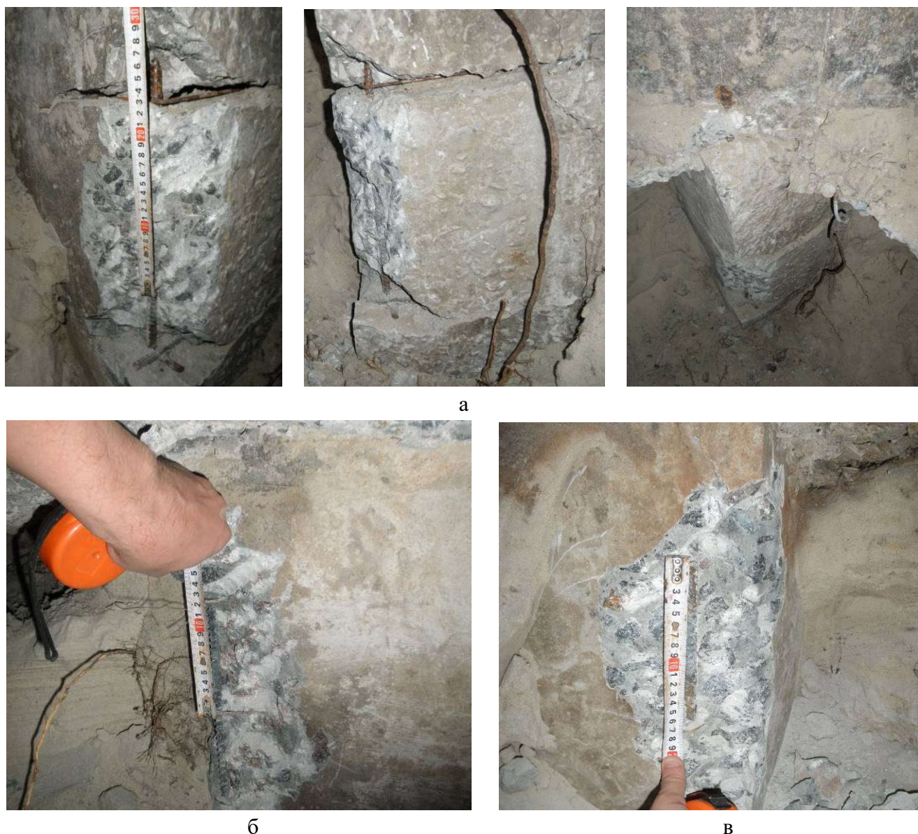
Рис. 2.19. Вигляд паль у ростверку з шурфів при дослідженні армування паль: а – паля №119 у шурфі №1; б – паля №105 у шурфі №2; в – паля №9 у шурфі №3
