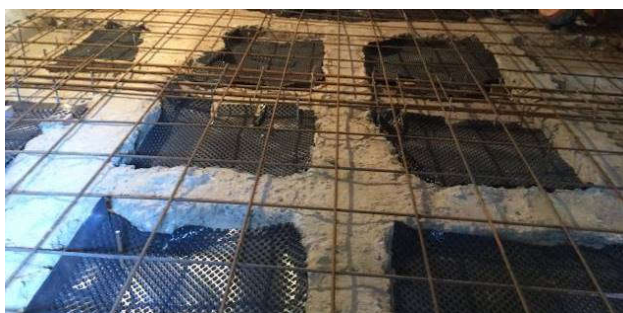
Рис. 5.3. Вигляд піщаної основи після її поверхневого ущільнення під плиту
