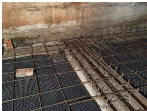
Рис. 5.4. Армування плити (шостий етап посилення фундаментів)
