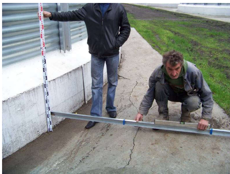
Рис. 1.1. Заміри параметрів вирви осідання навколо зерносквища
