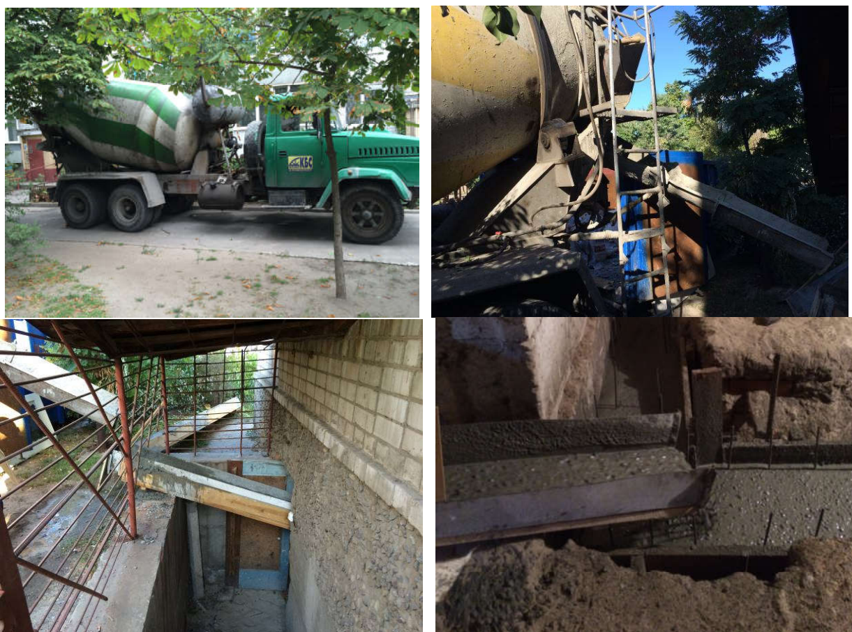
Рис. 5.6. Процес подачі бетону для улаштування балок посилення та плити
