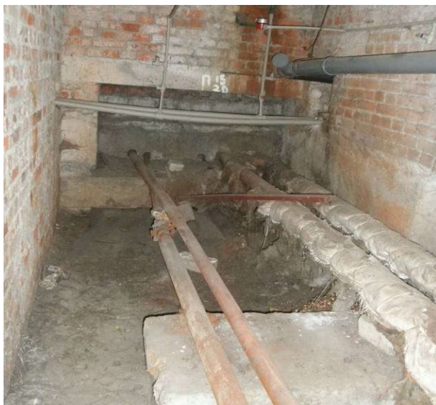
Рис. 2.3. Водонесучі комунікації у підвалі будівлі: а – вхід магістральної теплової мережі до підвалу, осі І-2 з боку осі В (ліва блок-секція); б – вигляд комунікацій
