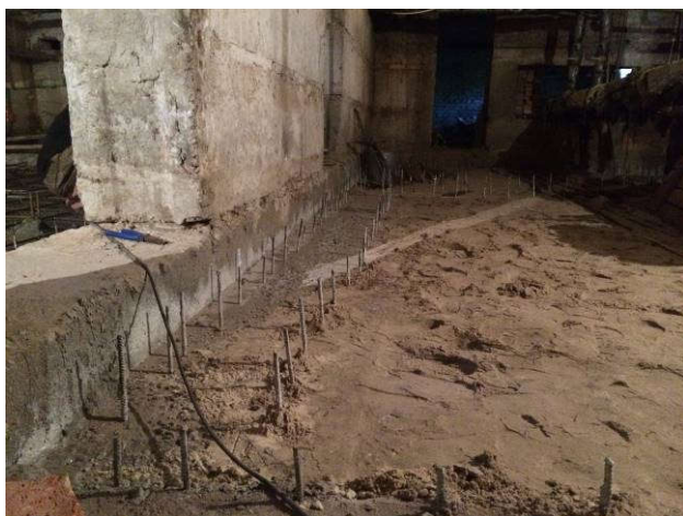
Рис. 5.3. Вигляд піщаної основи після її поверхневого ущільнення під плиту
