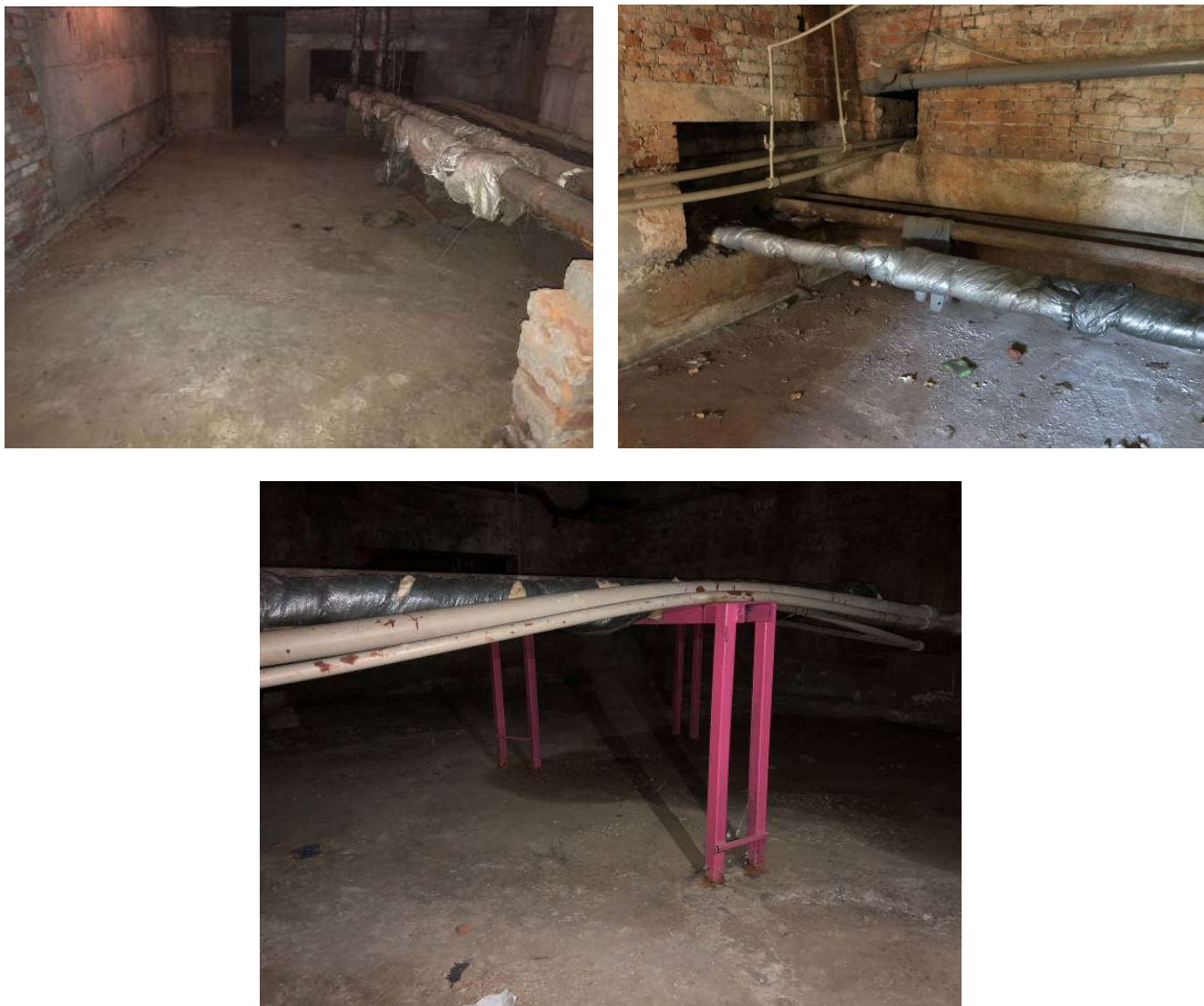
Рис. 5.7. Вигляд підвалу після завершення робіт з посилення фундаментів
