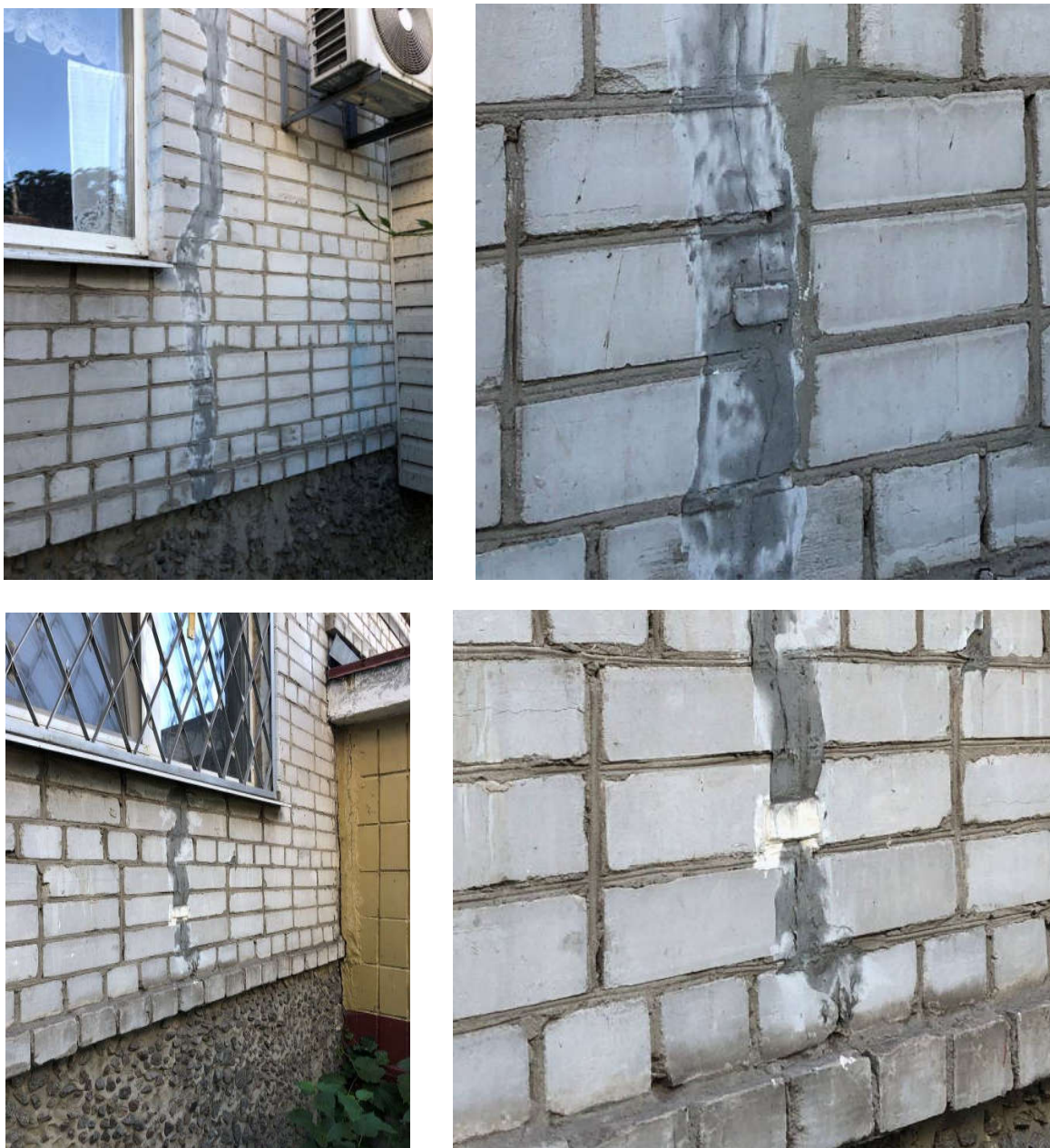
Рис. 5.8. Відновлені (після посилення фундаментів) маячки на тріщинах у зовнішніх несучих стінах будинку
