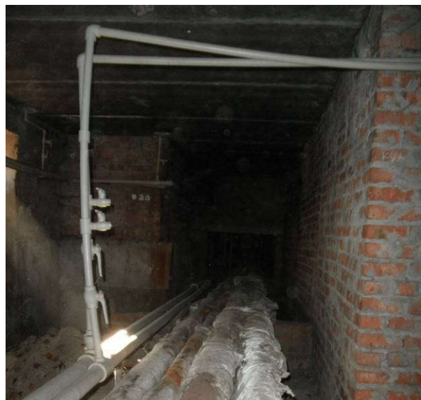
Рис. 2.3. Водонесучі комунікації у підвалі будівлі: а – вхід магістральної теплової мережі до підвалу, осі І-2 з боку осі В (ліва блок-секція); б – вигляд комунікацій
