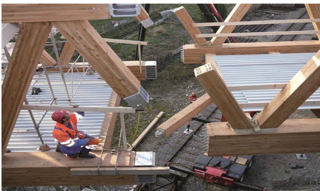
Рис. 1.15 Монтажний стик відправних марок ферми.
