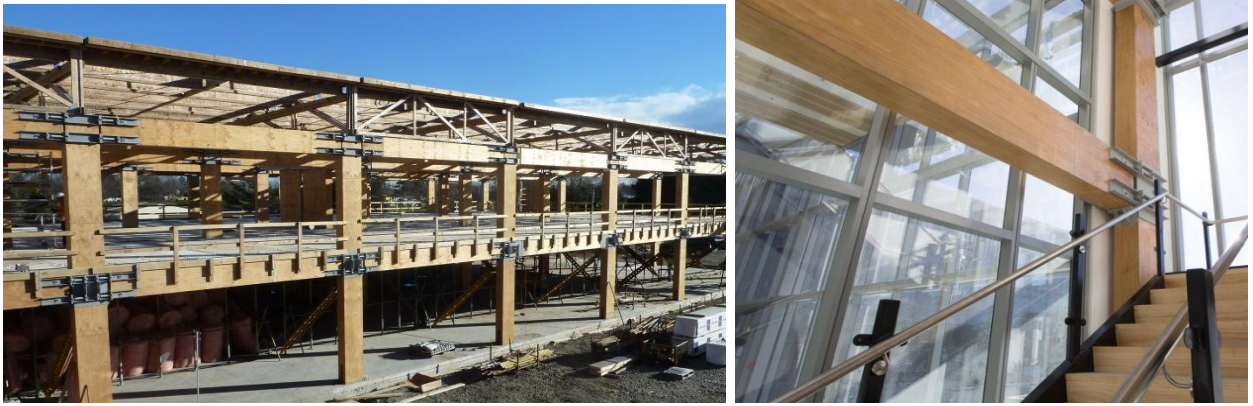
Рис. 1.8 Будівля з LVL бруса (Christchurch, New Zealand): а) загальний вид; б) вузол кріплення балки та колони.
