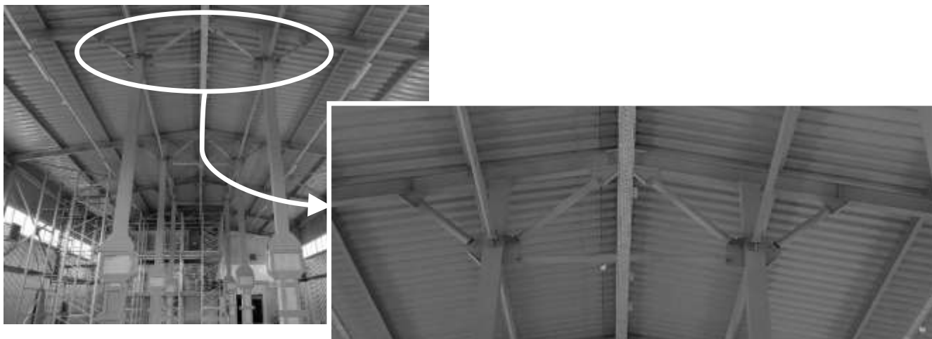
Рис. 2.6 – Встановлення підкосів між колонами і балками поперечних рам будівель
